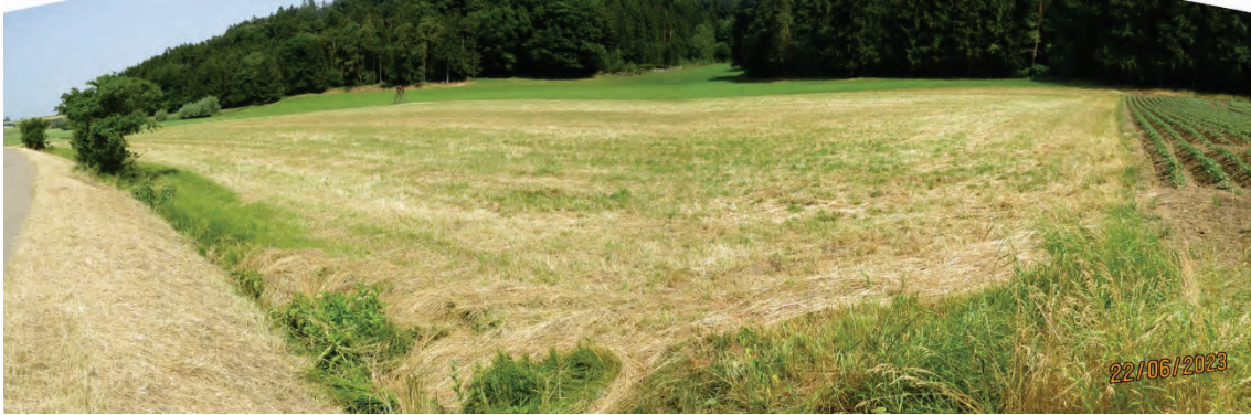
Abb. 4: Übersicht Planungsfläche Solarpark Igl (22.06.2023)
