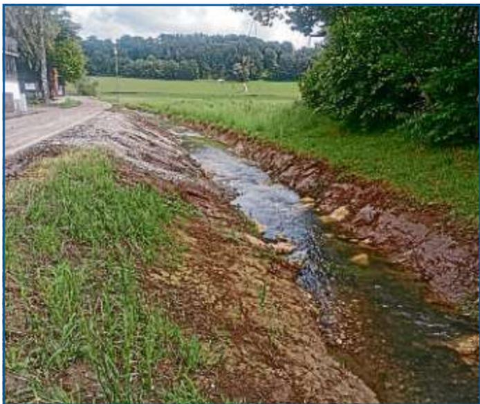
**Abgeflachtes Ufer und Entschlammtes Gewässer durch Kies und Wasserbausteine**
